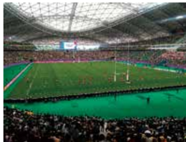
●大分スポーツ公園総合競技場
