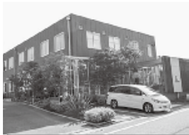
九州建産本社近景写真
